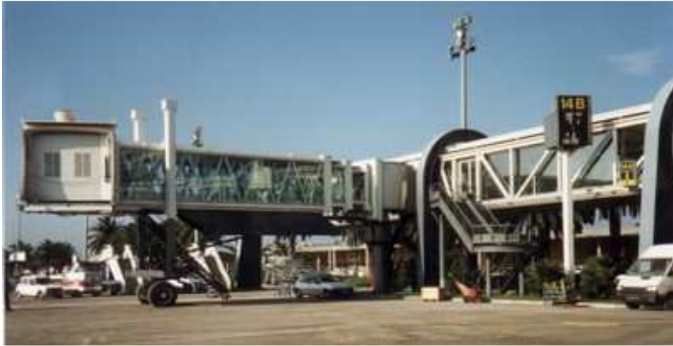
Photographie 1: Couloir Téléscopique d'aéroport
